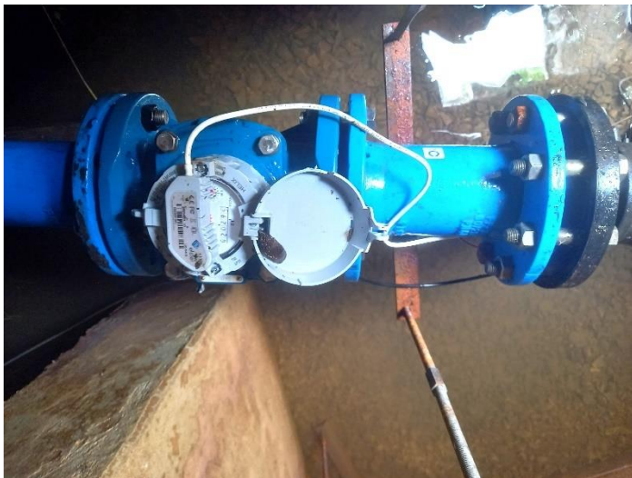
Obrázek 3 Sekční vodoměr a přenos informací
