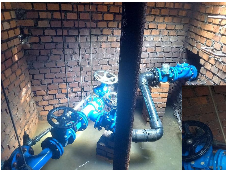
Obrázek 4 Rozdělení větví vodovodu
